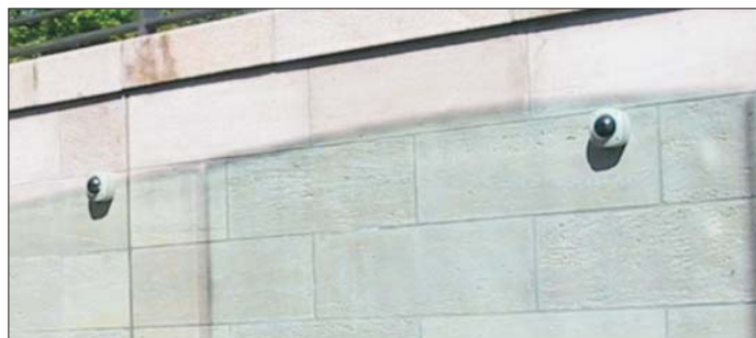
Lichtschrankenempfänger 30° in Dom-Kameragehäuse
